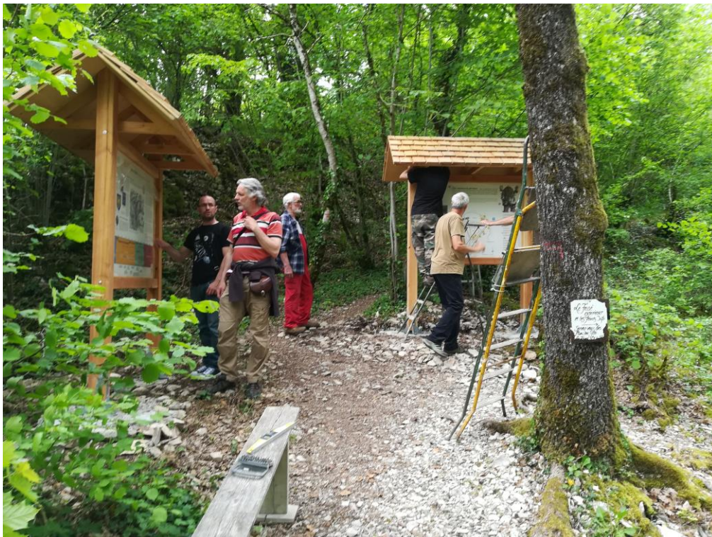
Installation des panneaux le long de la Serpentine.
